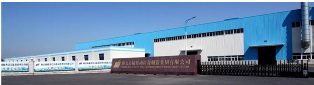
空港工业园厂区（466,000m 2 ）：维修、再制造
